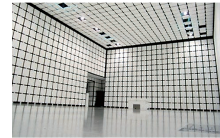
10 m 法電波暗室
