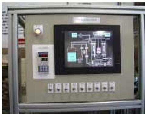
図8 排水処理装置における運用管理システム
