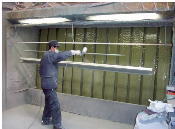
図1 ハンドスプレーによる吹付塗装 塗装ブース内で、人がスプレーガンを操作して塗料を霧状に吹付けます
