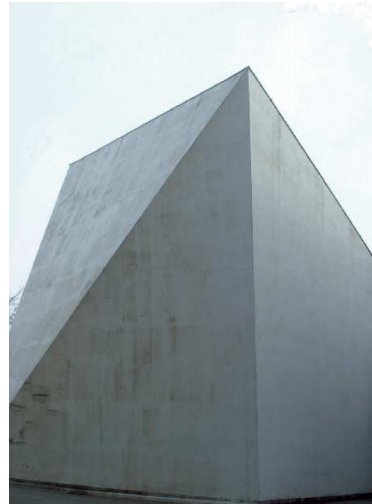
図2 残響室（不整形七面体の建物） 室内は、山びこのように響きます
