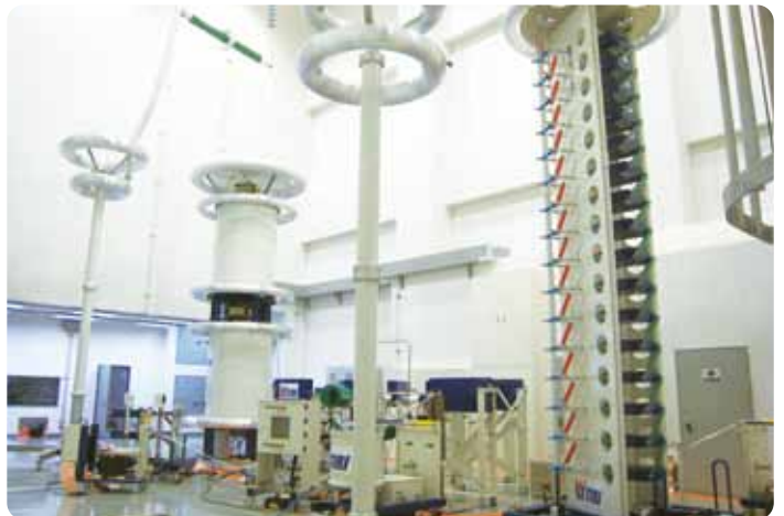
高電圧実験室の電磁波シールド
