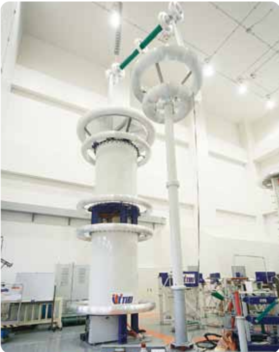
交流高電圧発生装置
