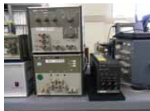
図6 直流電圧発生装置
