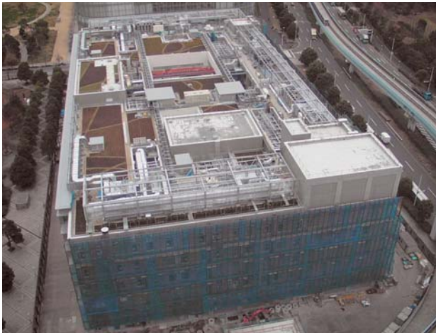
図1 新本部建設現場全景 (H22.12.13撮影)
