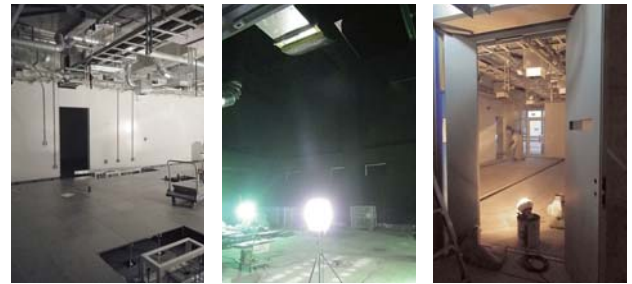
図3 環境化学、照明、バイオ応用室工事状況 左) 環境化学、中央) 照明、右) バイオ (H22.12.13撮影)
