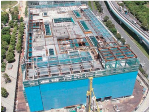
図1 新本部現場の建設工事状況 (全景H22.5.13撮影)
