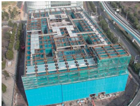
図1 新本部現場建築工事状況 (全景H22.3.16撮影)
