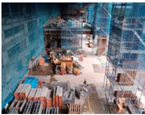
図2 エントランス から2階
