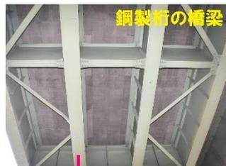
ドローンのバーを鋼製桁のH鋼に押し付け、そのままの状態で行進して撮影する。
