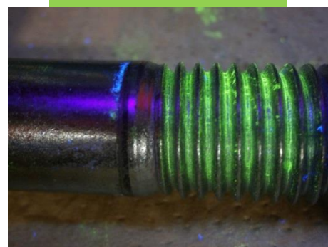
図1 ボルトの疲労割れ
