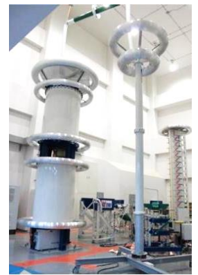
図2 Haefely製電圧発生装置
