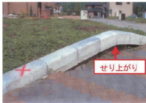
図1 DEFによるコンクリート膨張劣化事例
