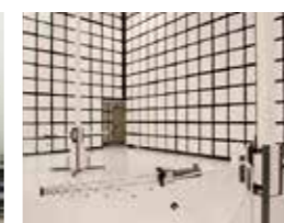
電子・機械グループ 放射エミッション測定システム
