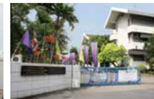
バンコク支所 外観
